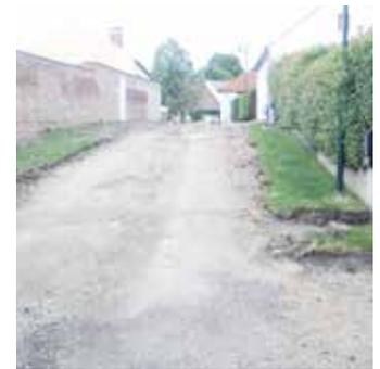
Der komplette Fahrbahnbelag wurde in Haugsdorf für die Fahrbahnsanierung abgetragen.
